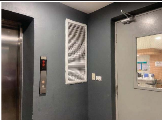
รูปที่ 2-24 ลิฟต์ฉุกเฉินและประตูหนีไฟที่ใช้ในกรณีเกิดอัคคีภัย
