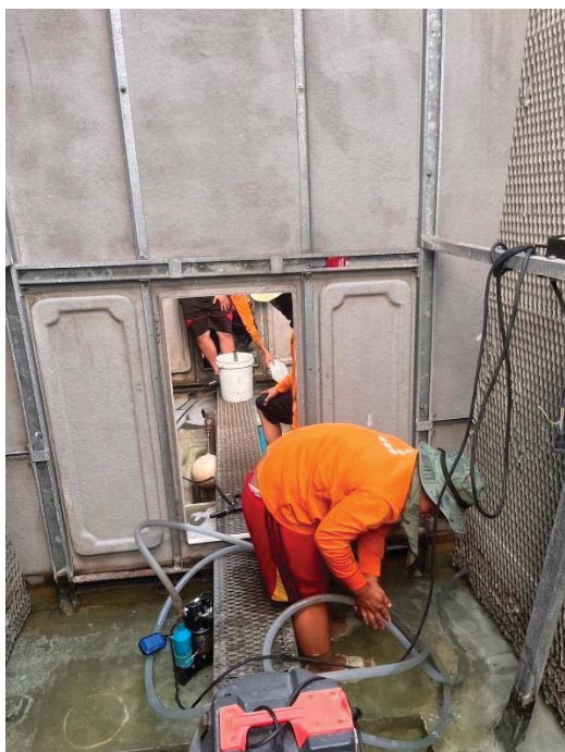
รูปที่ 2-6 หอฝึ่งเย็นของโครงการและการทำความสะอาด
